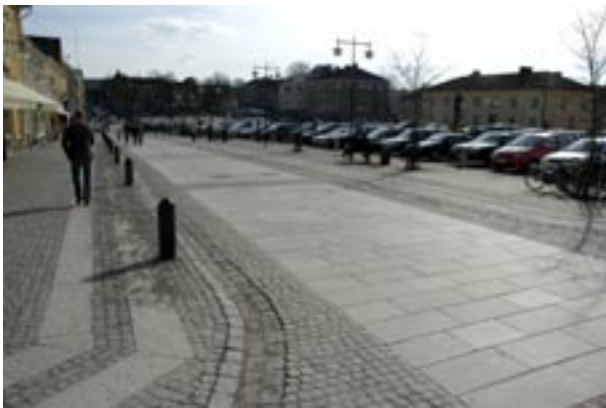
Fig 4.24 Gårdsgata med beläggning av granithällar och smågatsten
