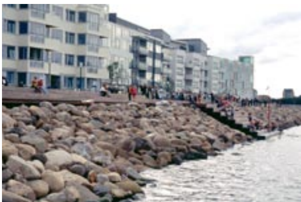
Fig 8.40 Släntbeklädning uppbyggd av runda fältstenar, som erosionsskydd mot havet.
