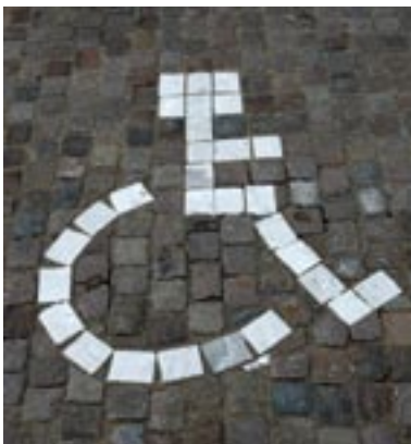
Fig 5.16 Gatsten med olika kulör kan användas för beständig markering i gatan.
