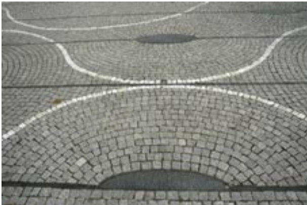
Fig 5.15 Smågatsten med olika kulör satt i objektpassat mönster.
