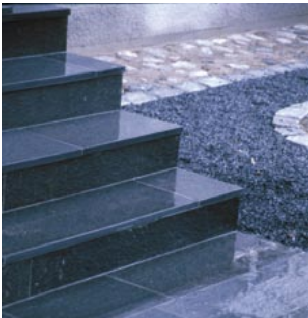
Fig 7.13 Beklädnadstrappa med steg av skiffer
