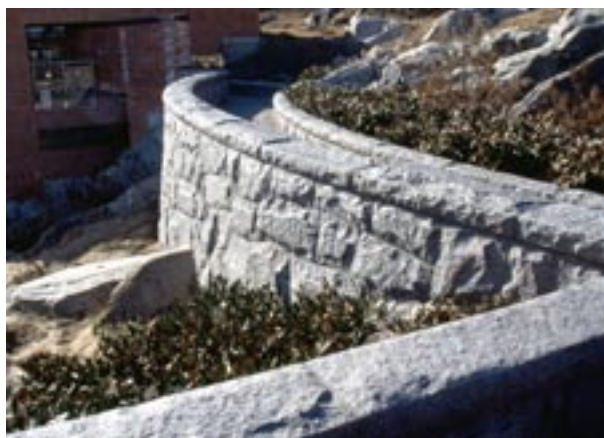
Fig 8.14 Mur av råkildad beklädnadsgranit, avtäckning av råkildad granit.
