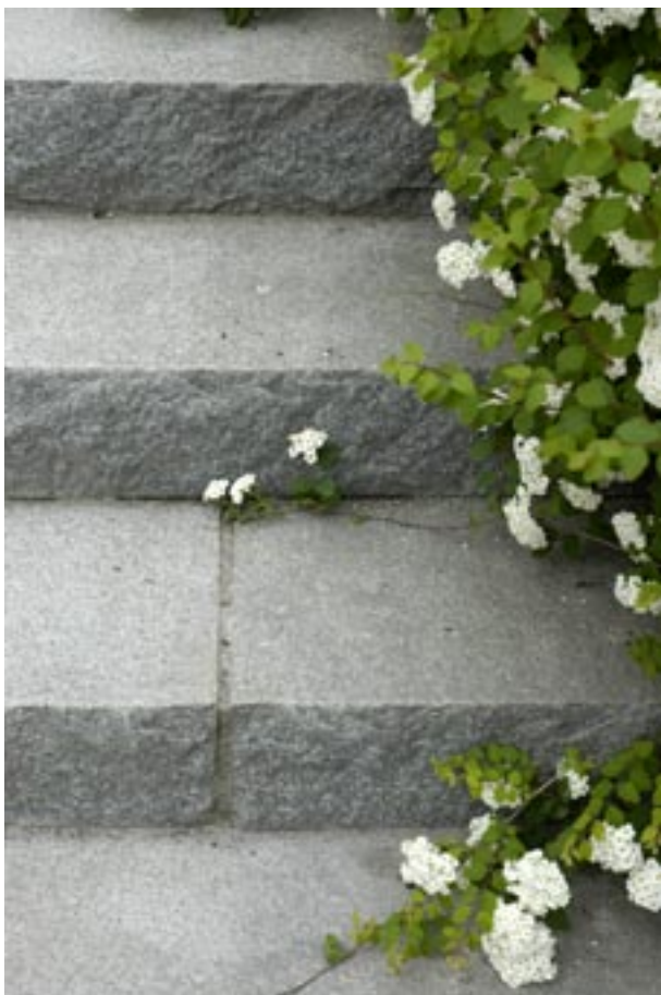
Fig 7.2 Blockstegtrappa av granit. Krysshämrad ovsida och råkilad framsida.
