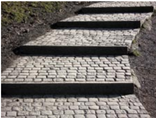
Fig 7.24 Åsnestig med sättsteg av kantsten och plansteg av gatsten
