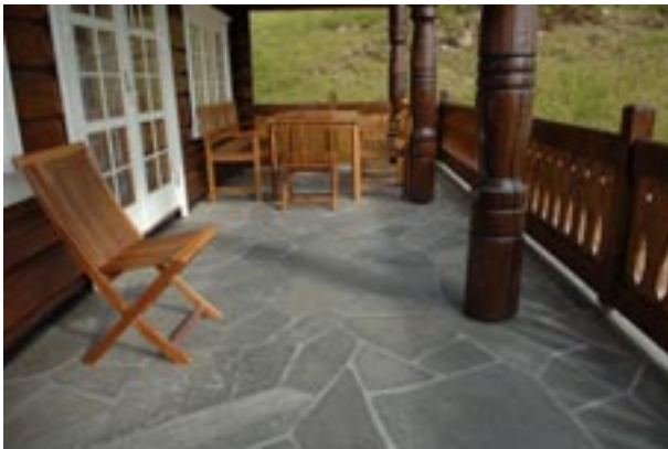
Fig 4.29 Altanbeläggning, skiffer med klovvyta.
