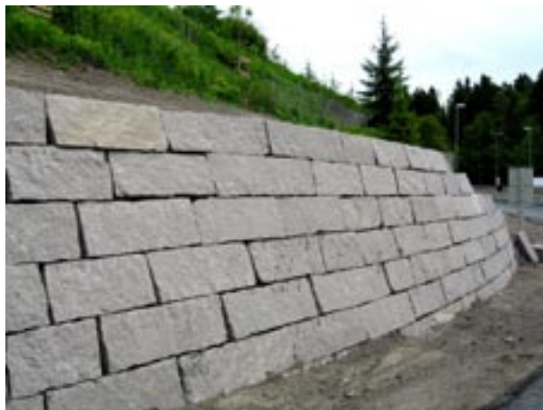
Fig 8.29 Kallmur av granitblock i vägskäring.
