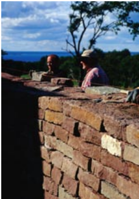
Fig 8.30 Montering av kalkstensskivor "flis" som kallmur.
