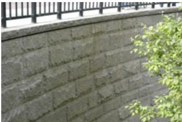
Fig 8.12 Svängd beklädnadsmur av grå granit med råkopp. Kvaderförband. Avtäckning av råkildad granit.
