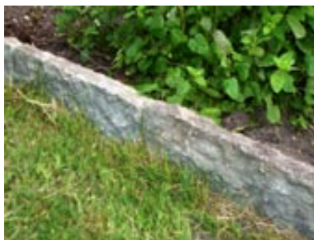
Fig 6.19 Trädgårdskantsten av kalksten
