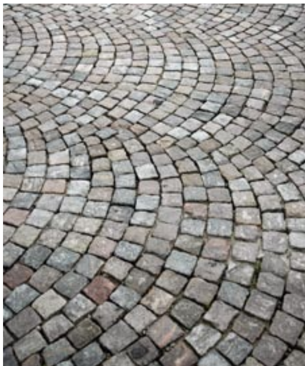
Fig 5.7 Bågsättning med smågatsten
