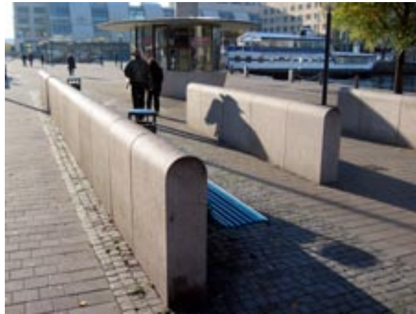
Fig 8.26 Blockstensmurar av flammad granit.
