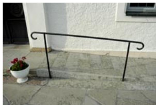
Fig 7.26 Låg ramp av kalksten för bättre tillgänglighet.
