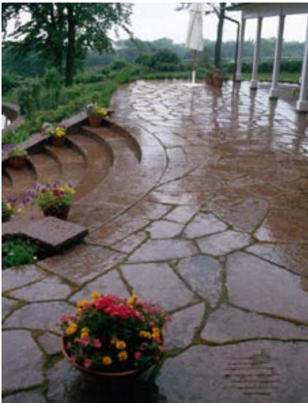
Fig 4.14 Altan med topphyvlad kalksten i oregelbundet mönster.
