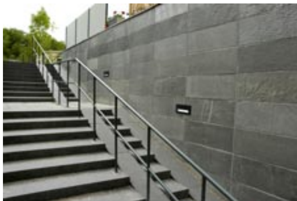
Fig 7.25 Barnvagnsramp integrerad i blockstegstrappa. Beklädnadsmur med skiffer.
