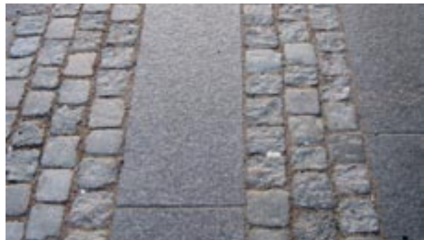
Fig 4.4 Granithäll med klippt kant mot gatstensbeläggning
