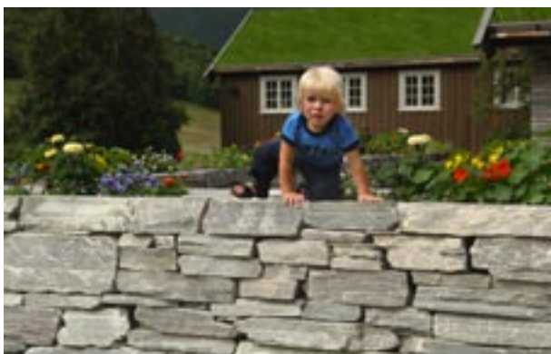
Fig 8.17 Kallmur av staplade skivor av skiffer
