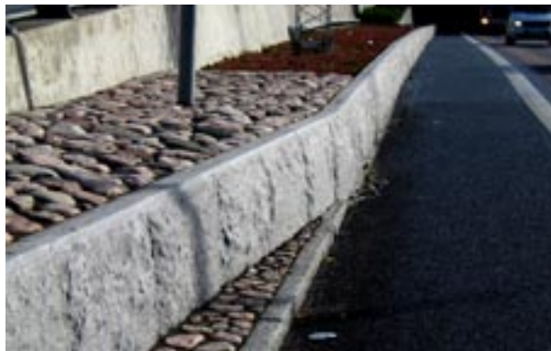
Fig 8.48 Blockstensmur av granit som stödmur och trafikbarriär
