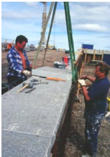
Fig 8.46 Granitavtäckning monteras
