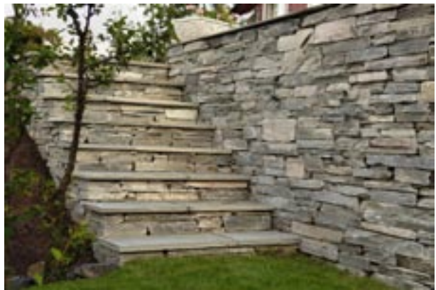
Fig 7.21 Skiffertrappa som utgör en integrerad del av muren.
