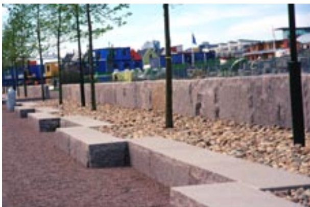
Fig 8.35 Två varianter av blockstensmur.
