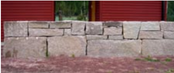
Fig 8.7 Kallmur av granitblock i rubbelförband
