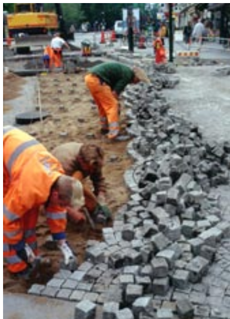
Fig 5.10 Bågsättning av smågatsten i sand
