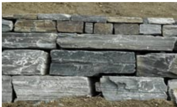
Fig 8.18 Kallmur av staplade skifferblock i kvaderförband.
