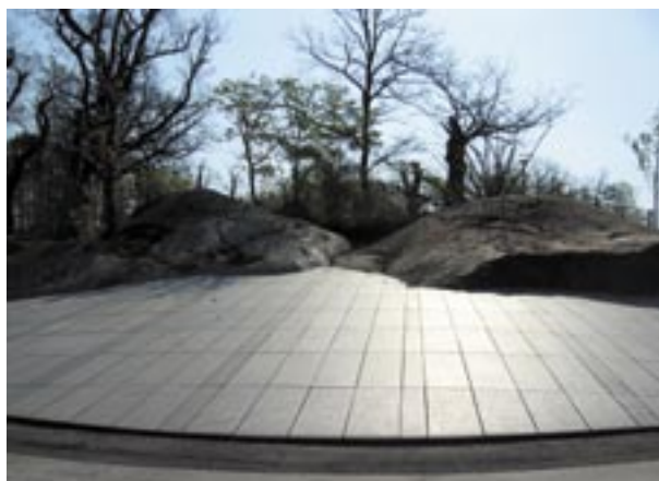
Fig 8.43 Släntbeklädning av granitplattor i parkmiljö.
