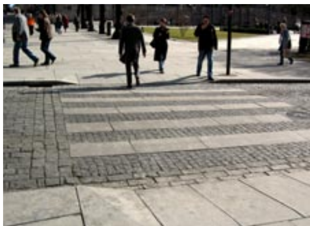
Fig 6.9 Tillgänglighetsanpassat övergångsställe.
