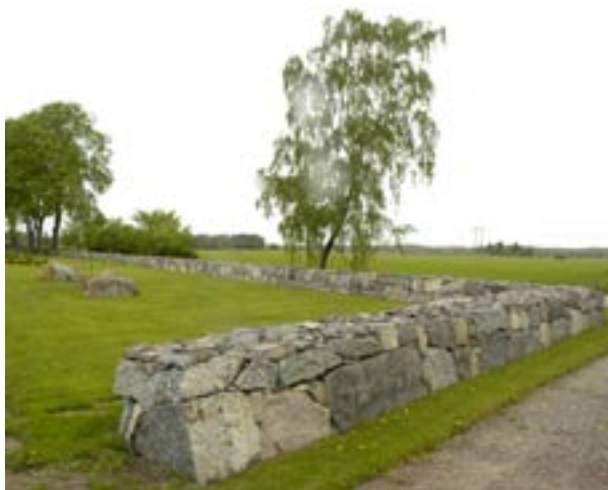
Fig 8.27 Kallmur av lokal sten, s k kyrkogårdsmur.
