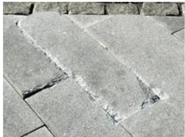
Fig 4.37 Granitbeläggning där plattkanterna har spjälkats ut. Smala fogar och alltför tung trafik i förhållande till underbyggnaden är troliga orsaker.
