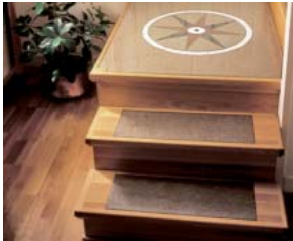
Fig 5.28 Trätrappa med kalksten infälld.
