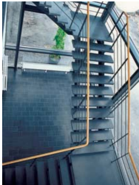
Fig 5.22 Trappa med fribärande steg på stålkonstruktion.
