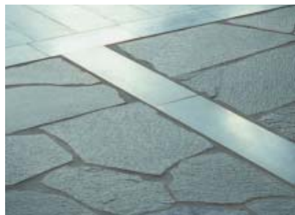
Fig 4.5 Detalj av kyrkgolv i skiffer med klovyta och kontrasterande finslipad yta.
