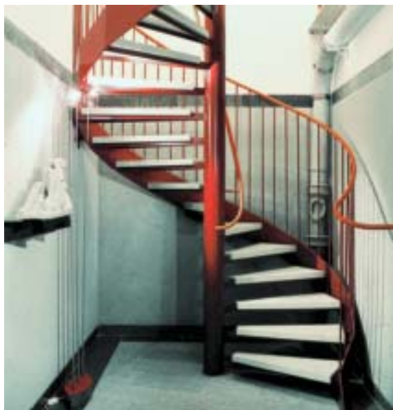
Fig 5.19 Stålkonstruktion med marmorsteg. Plattstål på högkant mellan mittspindeln och vangstycket är infällda i stegens undersidor och bär dessa.
