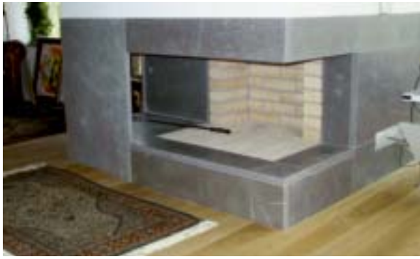
Fig 9.2 Inbyggd spis beklädd med kalksten. I själva eldhärden ligger eldfast tegel. Eldhärden är så djup att gnistskydd inte krävs på parkettgolvet.
