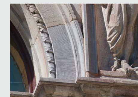
ANPASSAT. Stenprofiler som har tillverkats efter gamla förlagor för att passa ihop med befintlig sten.
