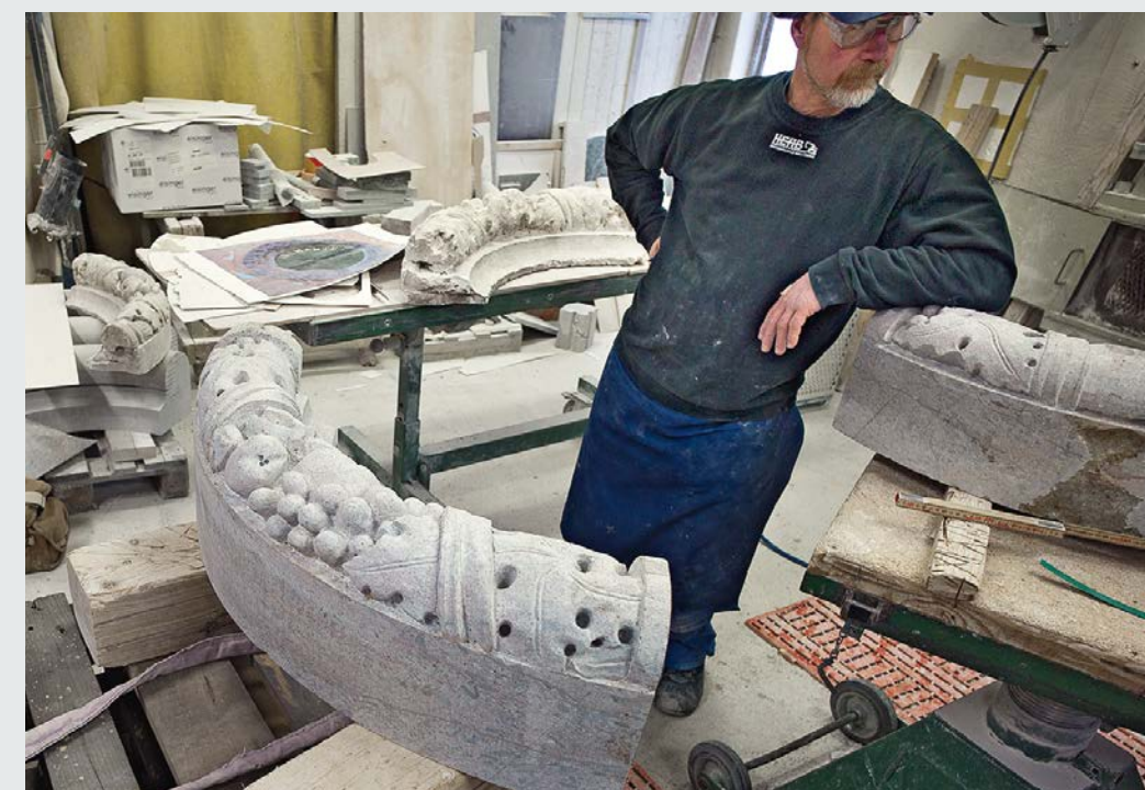
KLART. Stenhuggar- mästare Roger Larsson med två färdigställda kransbitar. På bilden nedan är de monterade på plats.
