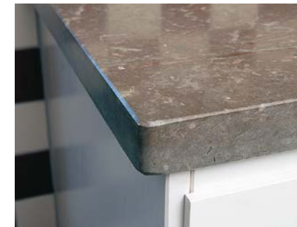
FASAD. Gråbrun Borghamnskalksten med rak fasad kant och normalrundat hörn.
