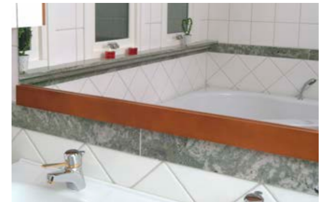
Kolmårdsmarmor har här använts både till en bård som går runt hela badrummet och till en fönsterbänk längs hela rummets bredd.
