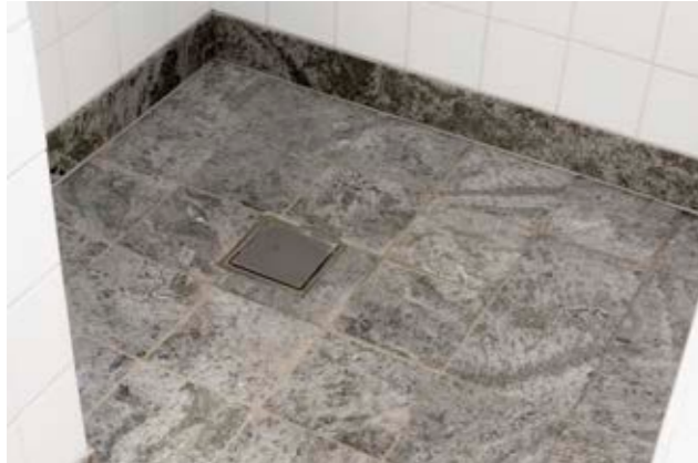
Duschrum med golv i slipad Kolmårdsmarmor, plattor i dimension 200 x 200 mm.
