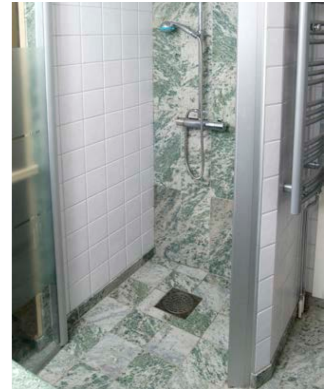
Genom att lägga ett schackmönster med sandsågad yta på varannan platta uppnås ett effektivt halkskydd.
