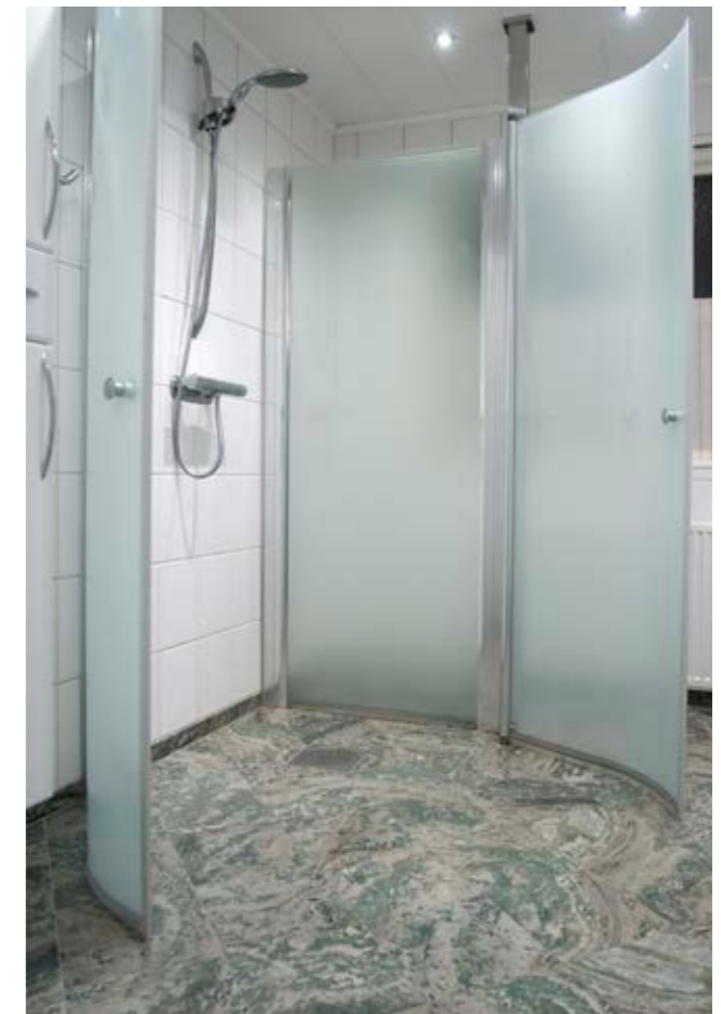
Duschhörna med golv i borstad Kolmårdsmarmor.
