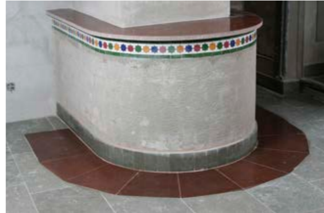
Pelaromfattning av röd kalksten med fris och golv i ljusgrå Borghamns kalksten.
