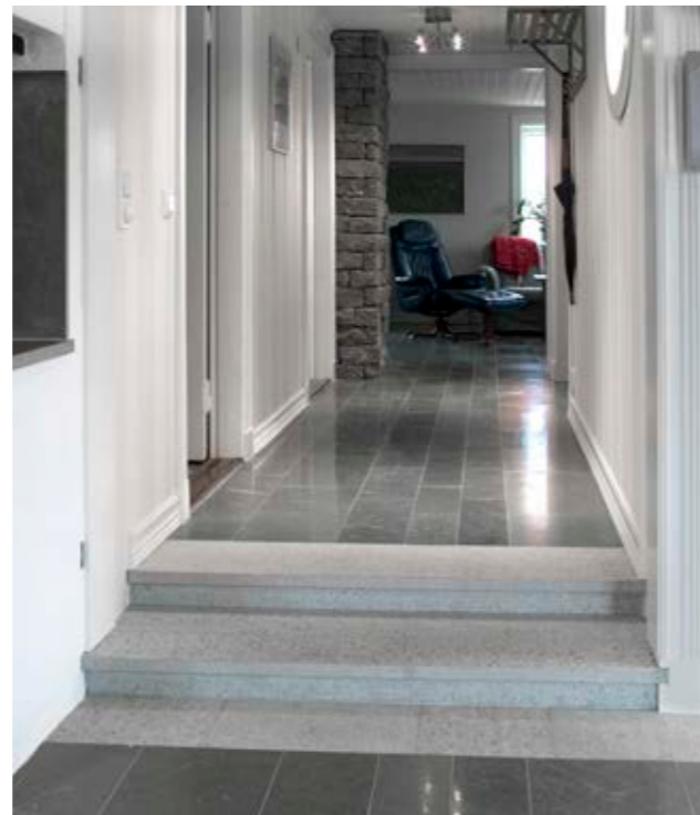
En traditionell hall i ett äldre hus som fått nytt golv i normalslipad samt trappsteg i hyvlad ljusgrå Borghamns kalksten.
