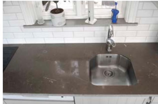
Diskbänk i gråbrun Borghamns kalksten där diskhon är tunnkantermonterad, det vill säga fäst underifrån i en ufräsning i kalkstensskivan.
